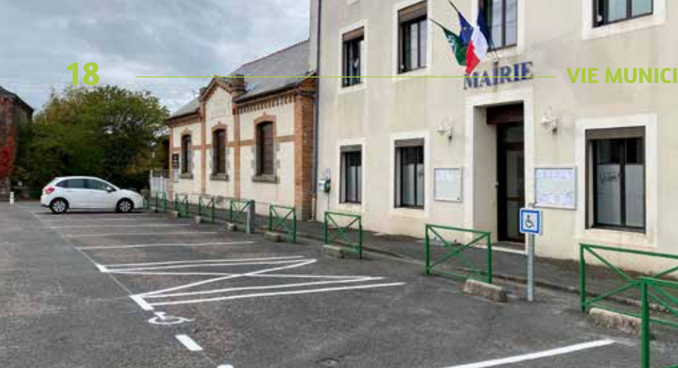
Peinture de signalisation horizontale
