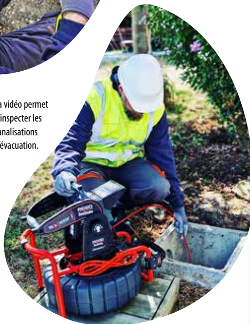
crédits photos : Enela Canalisations Services
