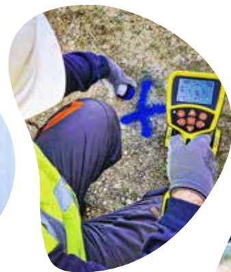
Un technicien localise une canalisation enterrée.
