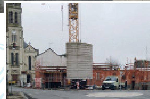
Les travaux sont en cours (à dr.) de ce qui deviendra le pôle santé de Nueil-sur-Layon.
