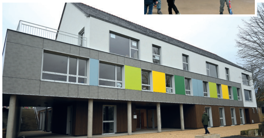
Avec ses 1 000 m 2 répartis sur trois niveaux, l'école peut accueillir jusqu'à 150 élèves. Elle compte cinq classes (toutes équipées d'un point d'eau et d'un espace de rangement), une salle de motricité, une bibliothèque, un dortoir, des locaux techniques et administratifs. La cour de récréation (photo du dessus) se situe, quant à elle, à l'arrière de ce bâtiment.
